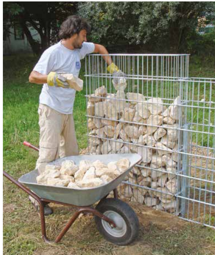
RANKO Gabione 26 bzw. 16 Typ 2m Breite ca. 2010 mm, Tiefe ca. 262 mm bzw. 165 mm
