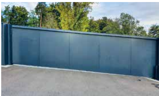
Schrägbau-Schiebetor mit Glattblechfüllung
