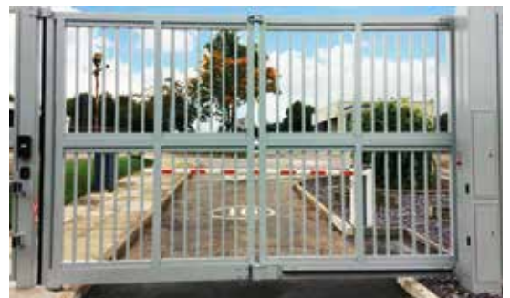
Falttor mit Stäben 30 x 30 mm (kein Schiebetor)
